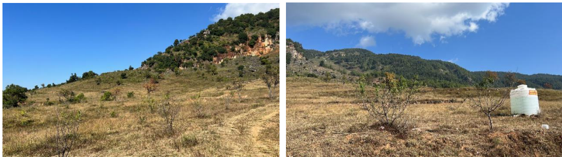
图 5.3-3 西区 1 号光伏项目现场照片
