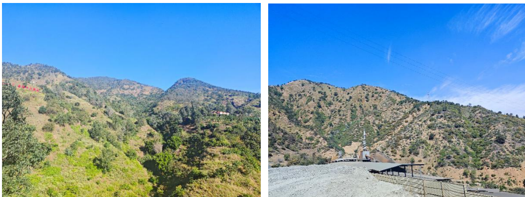
图 5.3-2 东区 1 号、4 号光伏项目现场照片
